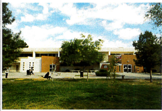
F1: Fachada principal
